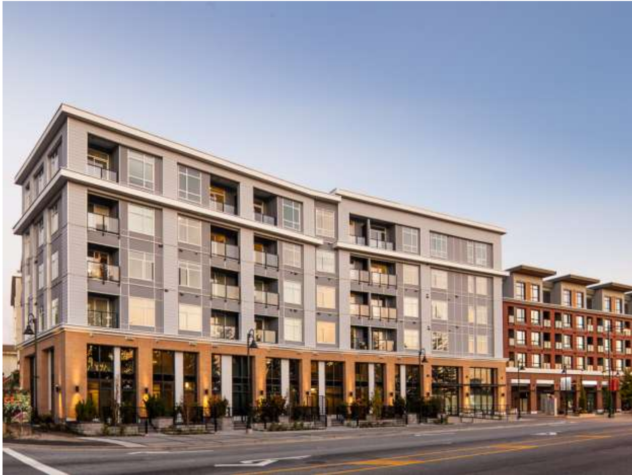
Projet Quattro, Vancouver; Photo Cotter Architects
